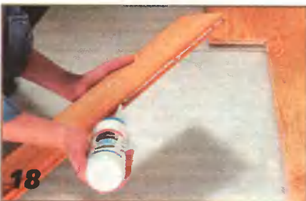
18 Наносят клей на заднюю стенку шпунтов, выбранных в продольных и торцовых кромках.
