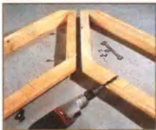
Трапецидальные рамки секторов стягивают друг с другом болтами с гайками.
