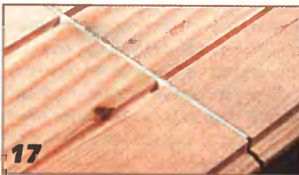
17 С помощью шнура проверяют правильность положения досок, которые предварительно укладывают всухую.
