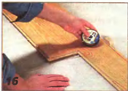
16 Точно выверив положение досок (если стены — кривые, используют клинья), приступают к их укладке.
