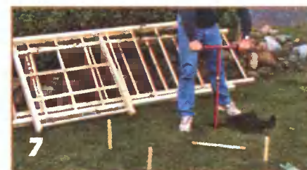
Ямы глубиной 80–90 см под столбы можно сделать ручным буром.
