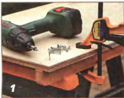
1 Бруски крепят к фанерному щиту скамьи шурупами с головками «впотаи».
