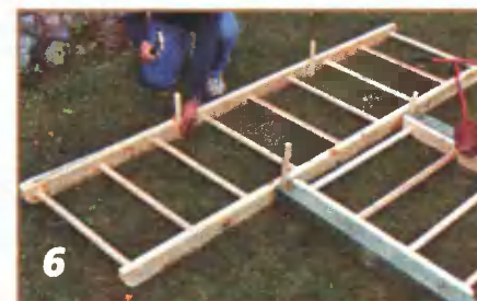
Разметка положения столбов. Расстояние между столбами должно точно соответствовать размерам «шведских» стенок.
