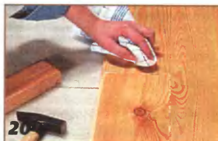
20 Выступившие излишки клея удаляют мягкой, чистой тряпкой.
