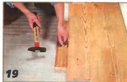
19 Пользуясь молотком и подкладочным бруском, доски плотно подгоняют одну к другой.
